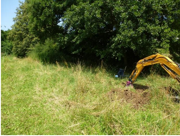
Foto 7: Standort Bodenprofil P4 vor dem Durchlass bei der Schleinikonerstrasse
