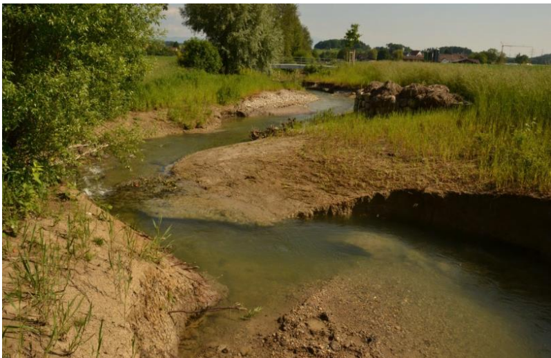
Abbildung 31: Beispiel für neu angelegte Mäander mit Steil- und Flachufem (Bildquelle: [7])
