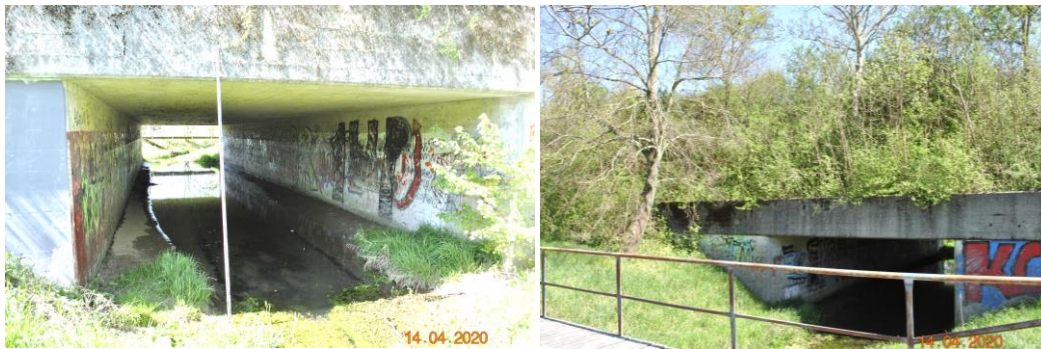
Abbildung 36: Durchlass Schleinikerstrasse, Ansicht in Fließrichtung (links) und gegen Fließrichtung (rechts).
