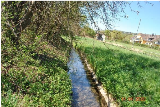
Foto 5: Bestehende Verbauung des Böschungsfusses.
