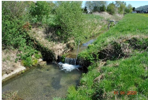
Foto 2: Bestehender Absturz vor Sandfang.
