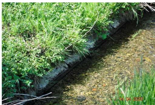
Foto 4: Bestehende Verbauung des Böschungsfusses.
