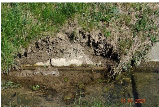
Foto 3: Bestehende Verbauung des Böschungsfusses.
